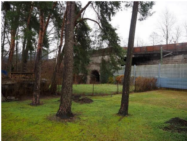
Abb. 11: Blick von Südwesten auf Gartenflächen, Überwerfungsbauwerk und Schallschutzwand
