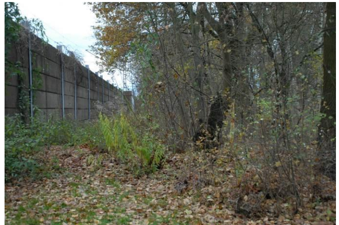
Abb. 3: Bereich südlich Zugangstor der Schallschutzwand
