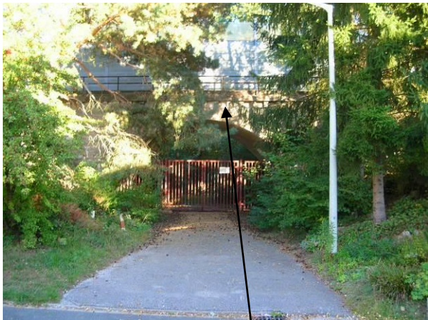
Abb. 17: Blick nach Osten auf Kastnerbrücke, Zufahrt vom Königshofer Weg
