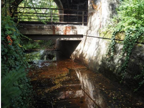
Abb. 6: Blick nach Osten auf Bauwerk (EÜ) über Entengraben mit Überwerfungsbauwerk
